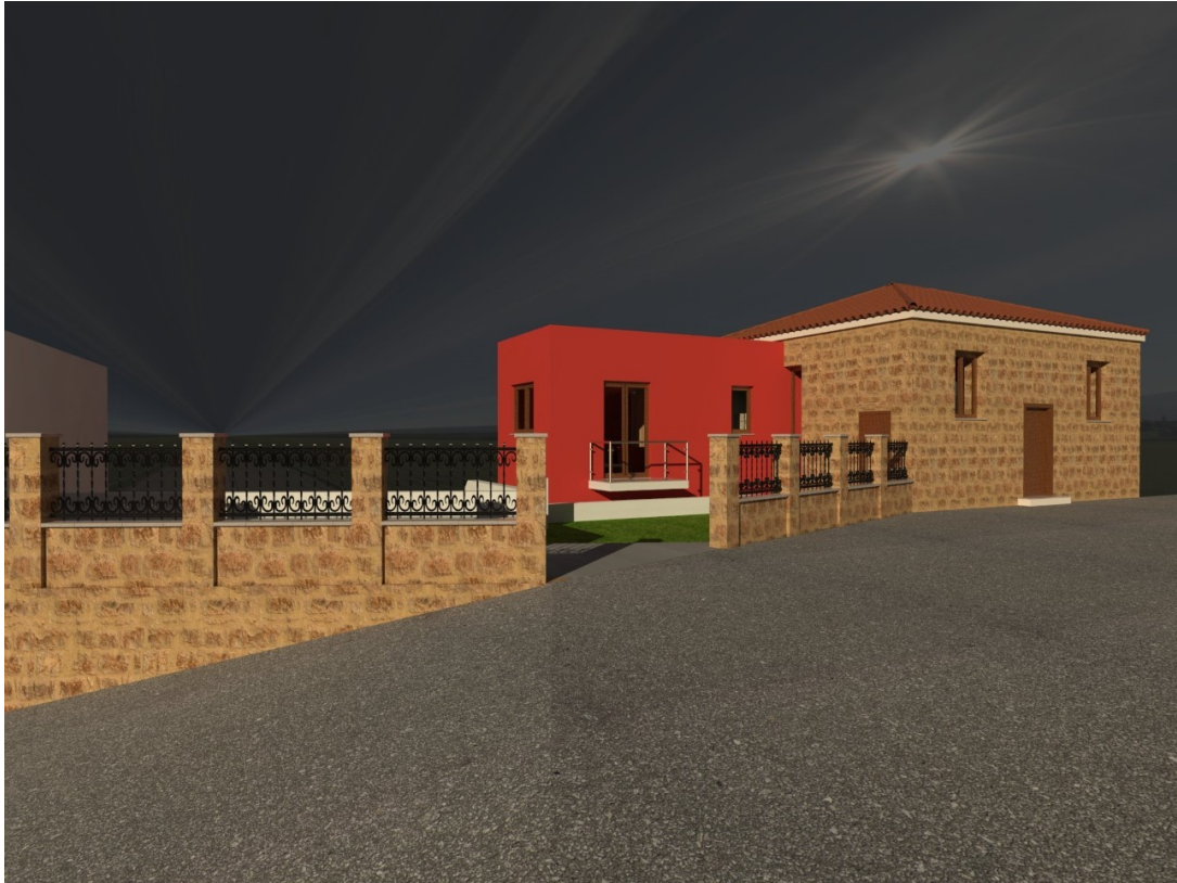
ΠΡΟΣΟΨΗ ΚΤΙΡΙΟΥ ΑΠΟ ΤΗΝ ΠΛΕΥΡΑ ΤΗΣ ΠΕΡΙΦΡΑΞΗΣ)
