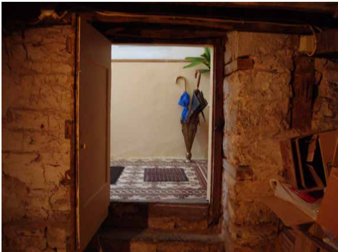
Εικ. 21:Εσωτερική πόρτα υπογείου
