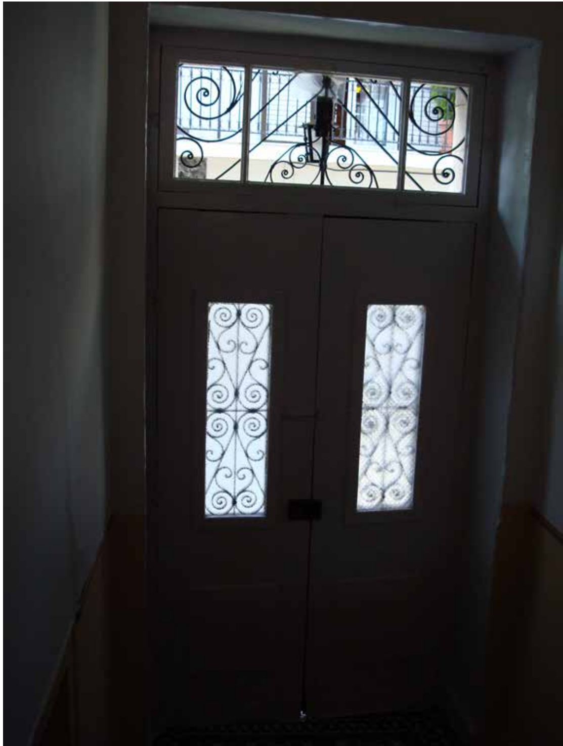
Εικ. 26:Εσωτερική όψη κεντρικής εισόδου
