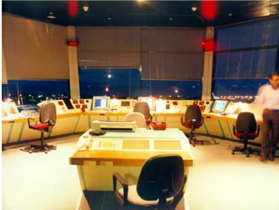
Αεροδρόμιο Ελληνικού, εσωτερικό Πύργου Ελέγχου. 4
