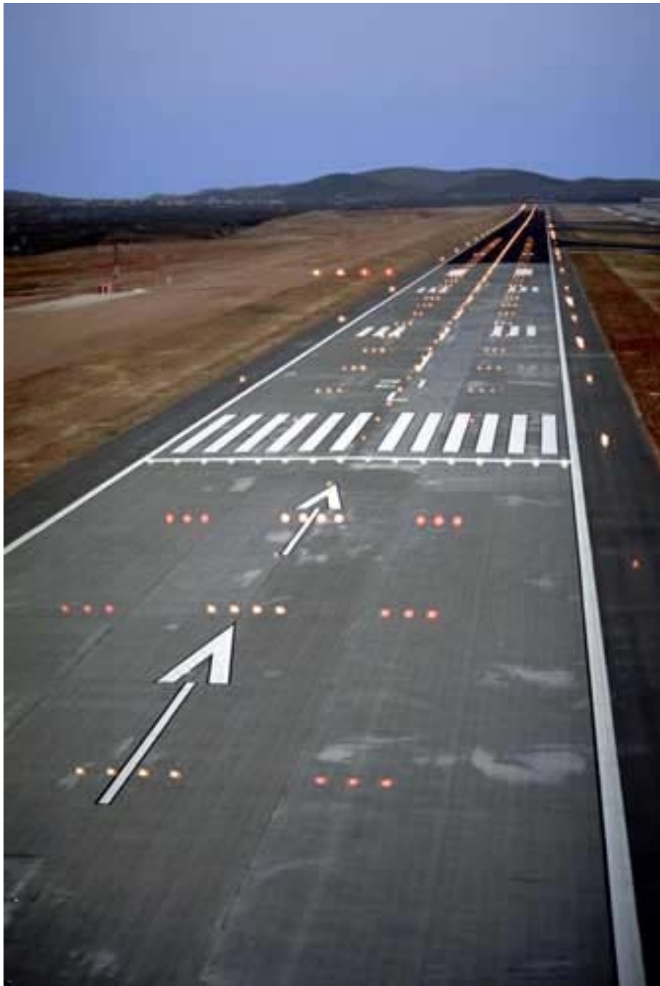
Φωτ.3.1: Δυτικός Διάδρομος αεροδρομίου «Ελ. Βενιζέλου» (Σπάτα). 11
