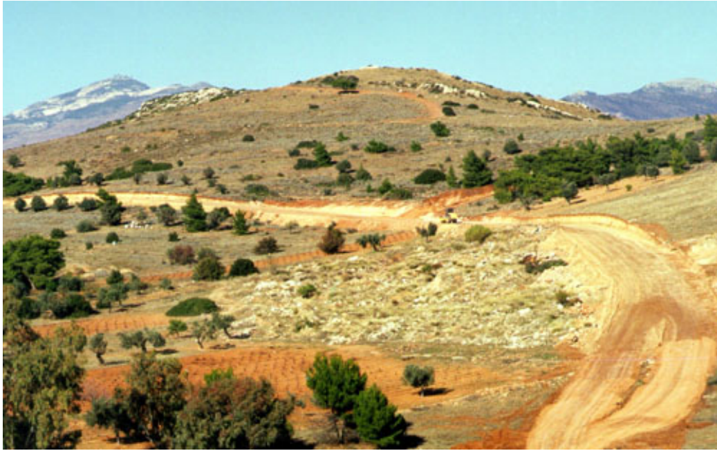
Απομάκρυνση εμποδίων- καθαίρεση λόφου από Αεροδρόμιο Σπάτων 50
