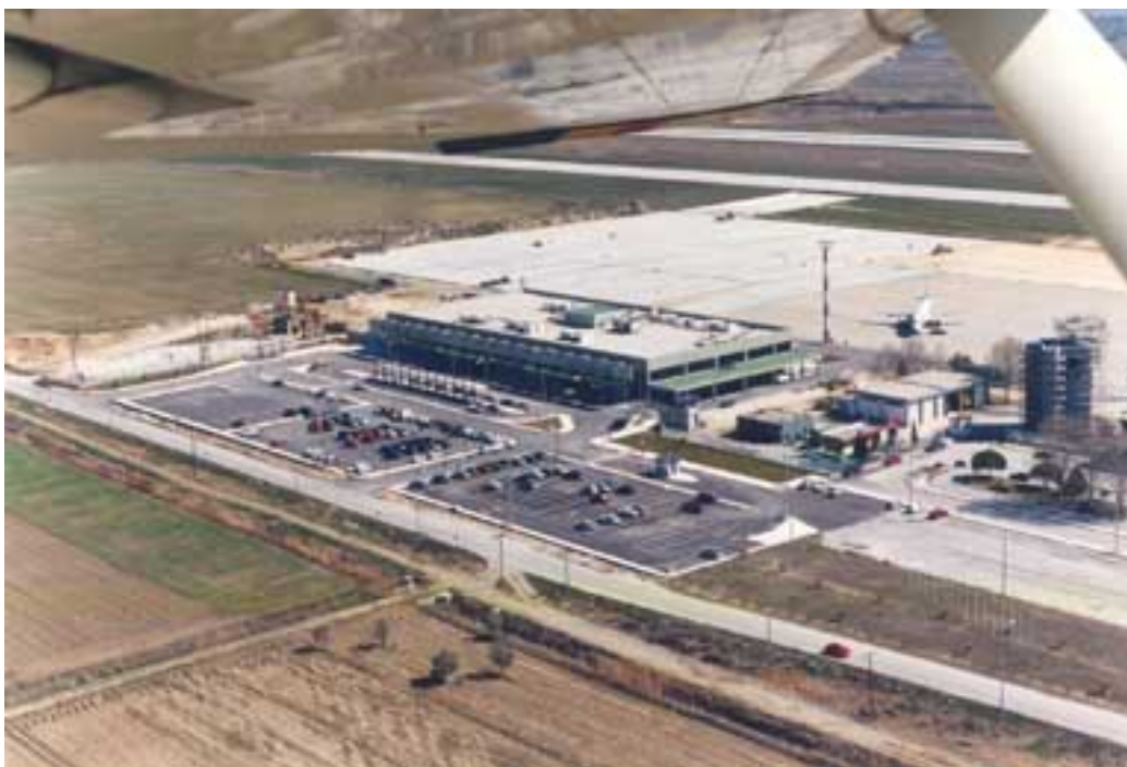
Φωτ 3.16: Αεροσταθμός αεροδρομίου «Μέγας Αλέξανδρος» (Καβάλα). 77
