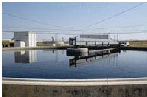
Αεροδρόμιο Σπάτων, Βιολογικός Καθαρισμός 2
