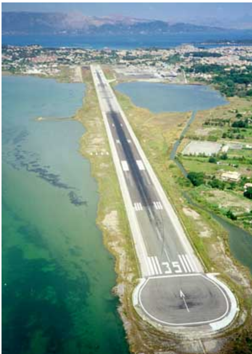
Φωτ.3.7: Διάδρομος και τροχοδρόμος αεροδρομίου Κέρκυρας. 51
