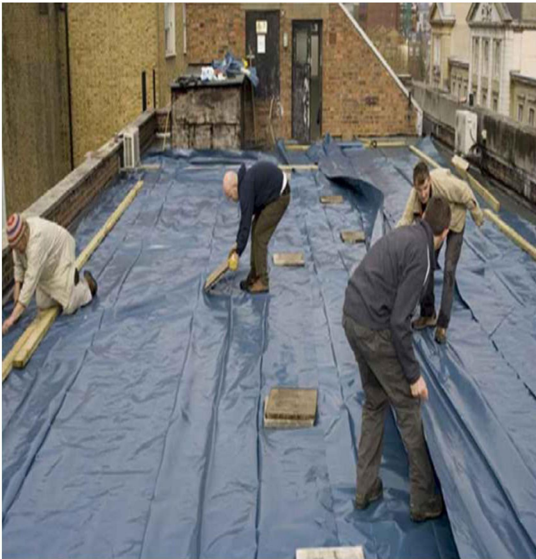
Εικόνα 2. Τοποθέτηση αδιάβροχης μεμβράνης.
