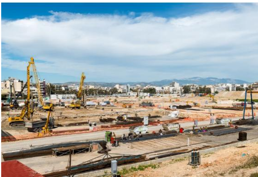
Σχήμα 17: Άποψη της κατασκευής του έργου ( www.snfcc.org )
