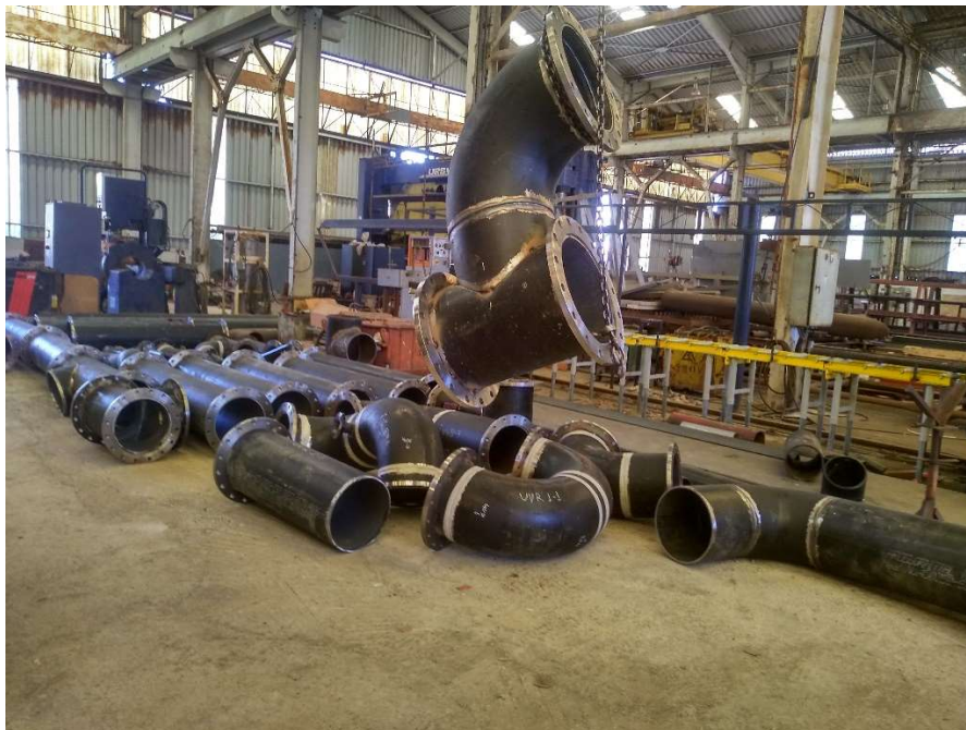
Εικόνα 107: Όλες οι σωληνώσεις του συστήματος μετά το πέρας κατασκευής τους.
