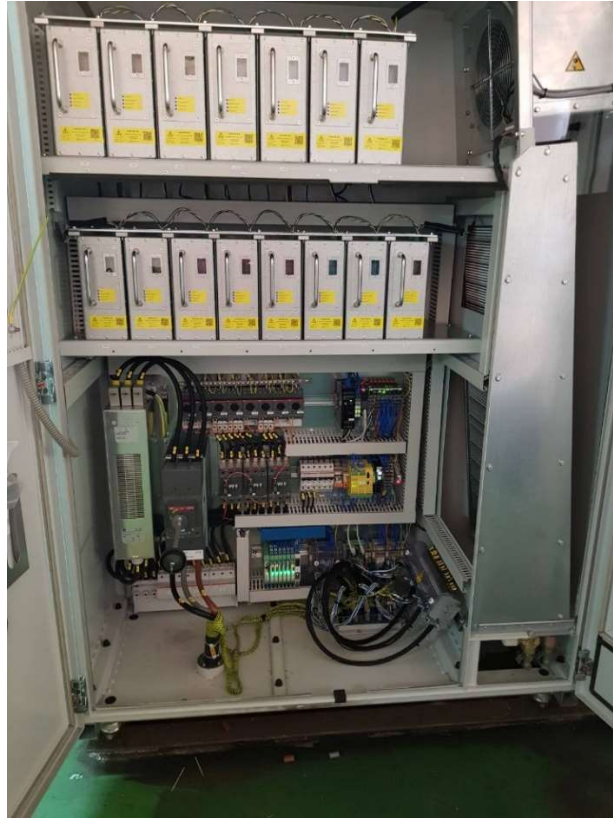
Εικόνα 116: Τοποθέτηση Ηλεκτρολογικού πίνακα.
