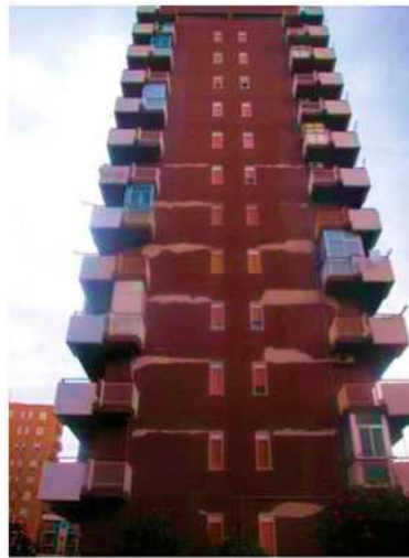
Σχήμα 2-4. Θετική συμβολή των τοιχοπληρώσεων στην αντισεισμική αντίσταση μιας δομής πλαισιωμένης με Ω/Σ. (Koutromanos et al., 2011)
