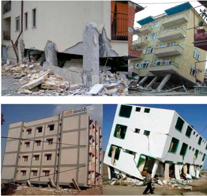
Σχήμα 2-1: Παραδείγματα καταρρεύσεων λόγω ακανόνιστης κατανομής τοιχοπλήρωσης καθ' ύψος. (Fiore et al., 2012)
