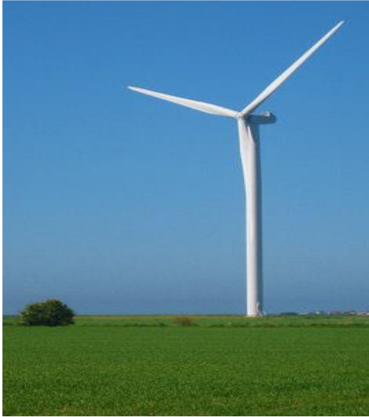
Εικόνα 7: Ανεμογεννήτρια οριζοντίου άξονα.
