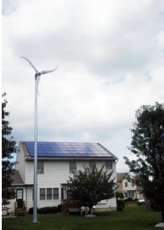
Εικόνα 16: Μικρό υβριδικό σύστημα σε κατοικία.
