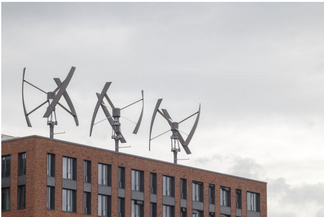
Εικόνα 17: Μικρές ανεμογεννήτριες κατακόρυφου άξονα σε κτήριο.
