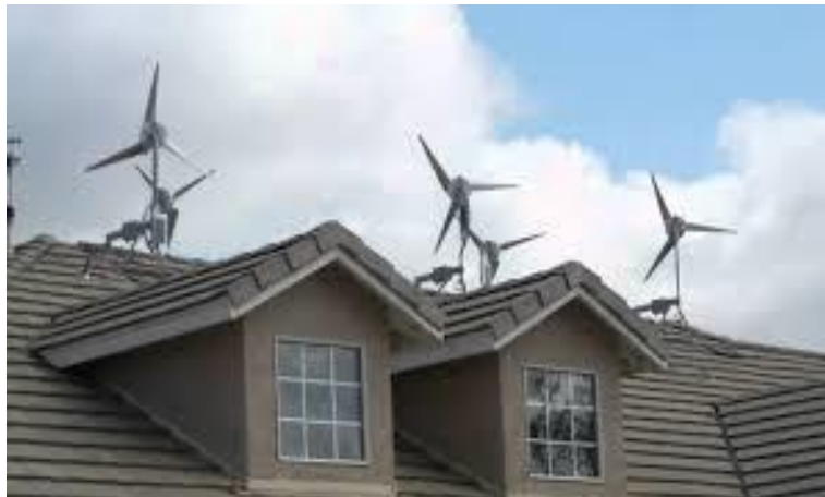
Εικόνα 13: Μικρές ανεμογεννήτριες σε οροφή κτηρίου.
