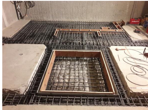
Σχήμα 2.1 Οπλισμός φατνώματος.
