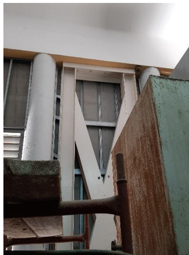
Σχήμα 2.4 Όπλιση με χιαστί συνδέσμους.
