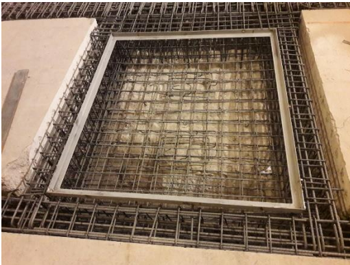
Σχήμα 2.1 Οπλισμός φατνώματος.
