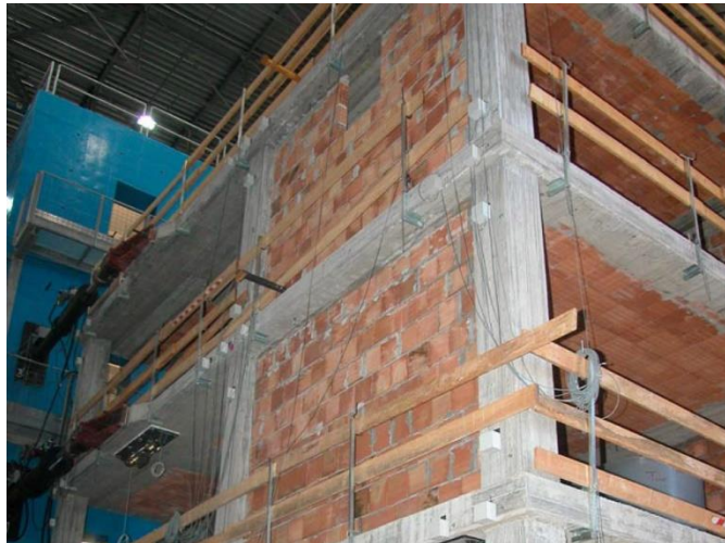
Σχήμα 3.1 Κατασκευή Οπλισμένου Σκυροδέματος
