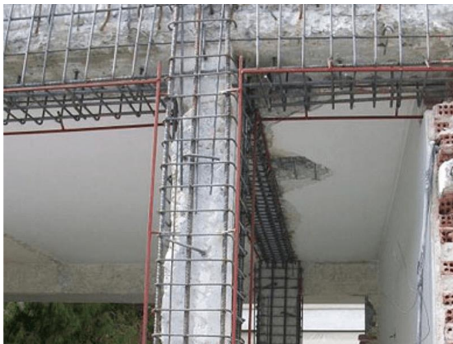
Σχήμα 1.3 Ενίσχυση υποστυλωμάτων.
