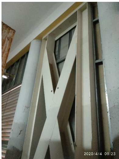
Σχήμα 2.4 Όπλιση με χιαστί συνδέσμους.
