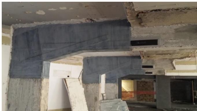
Σχήμα 2.6 Ενίσχυση με χρήση FRP .
