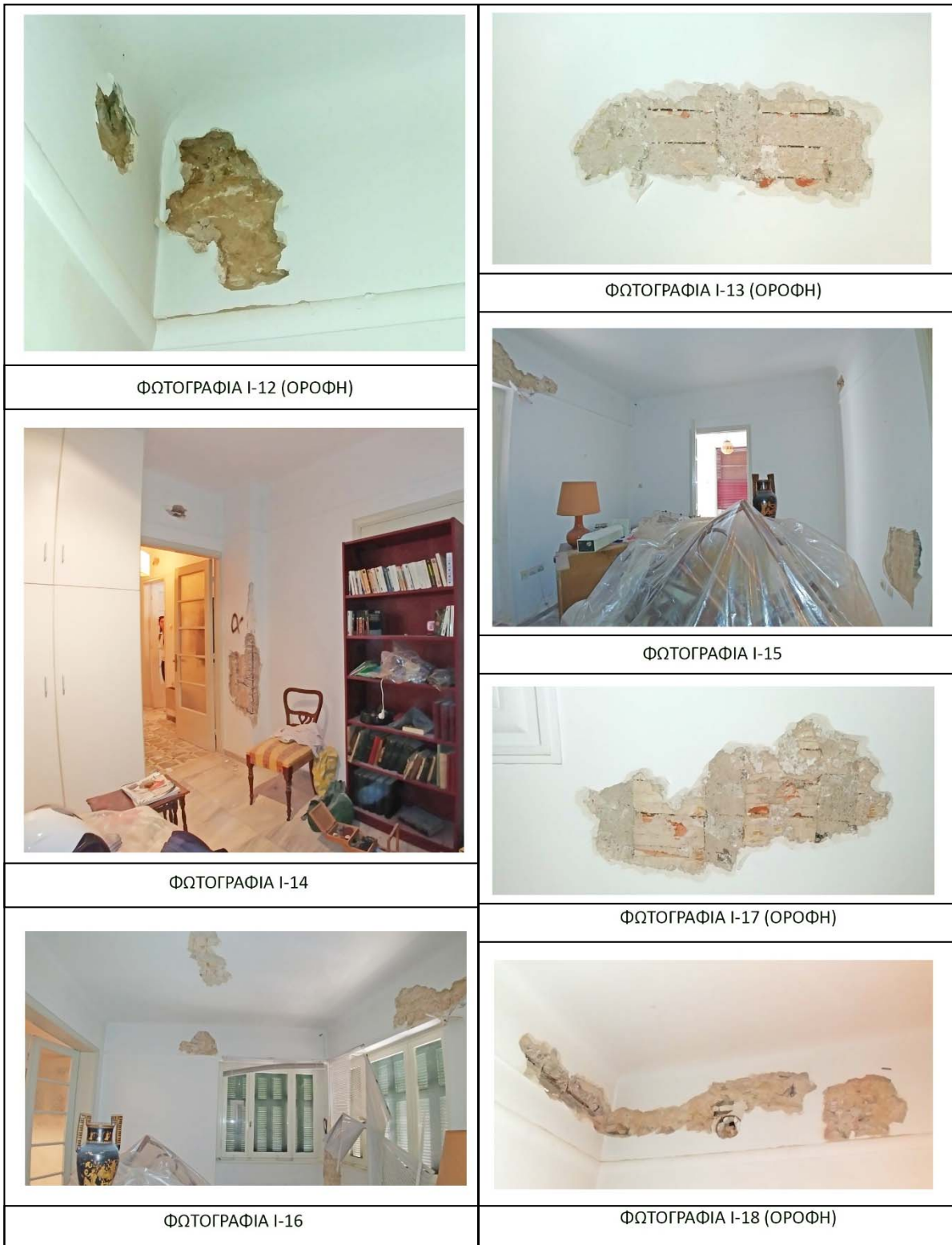
Εικόνα 1-5-3: Φωτογραφίες Ισογείου I-11 - I-18
