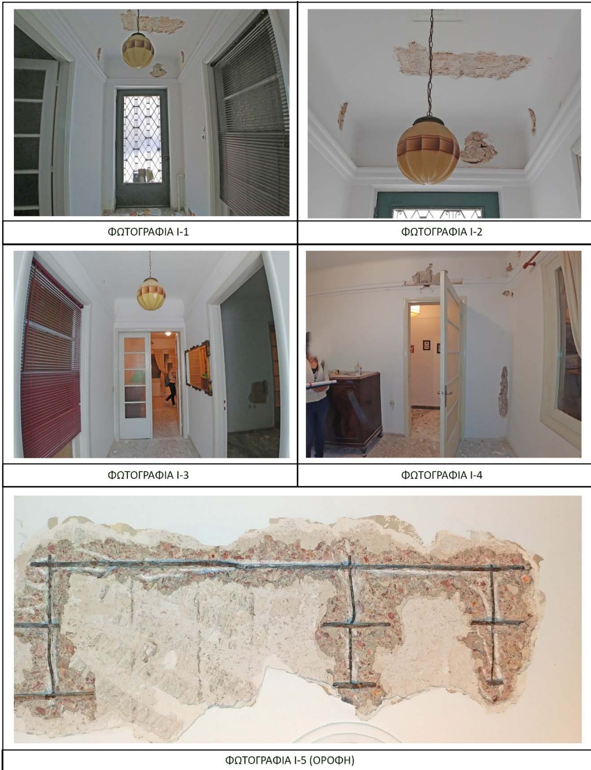
Εικόνα 1-5-1: Φωτογραφίες Ισογείου I-1– I-5
