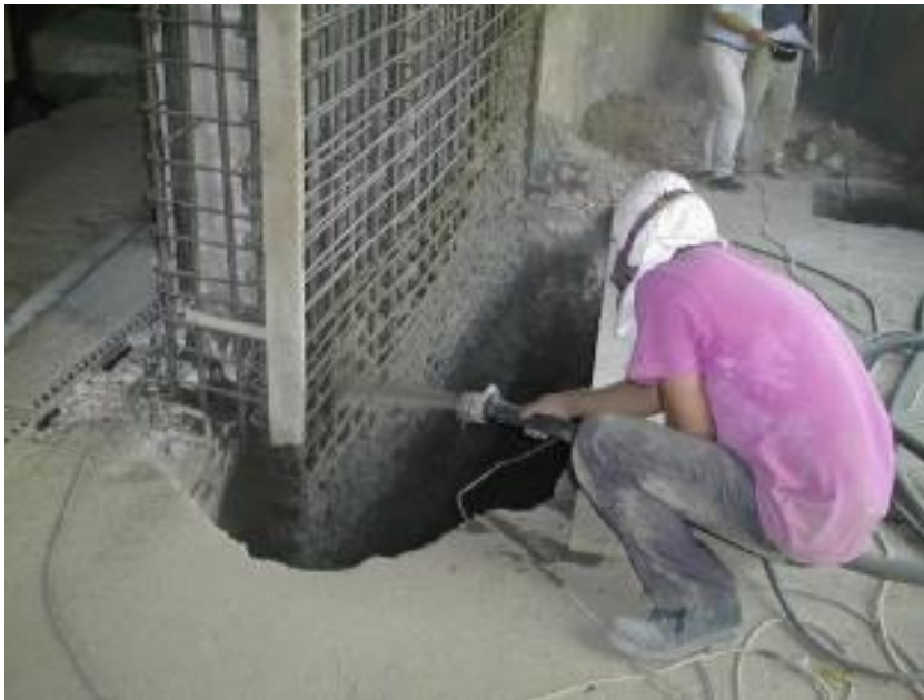
Εικόνα 3: Ενίσχυση υποστρώματος με εκτοξευόμενο σκυρόδεμα
