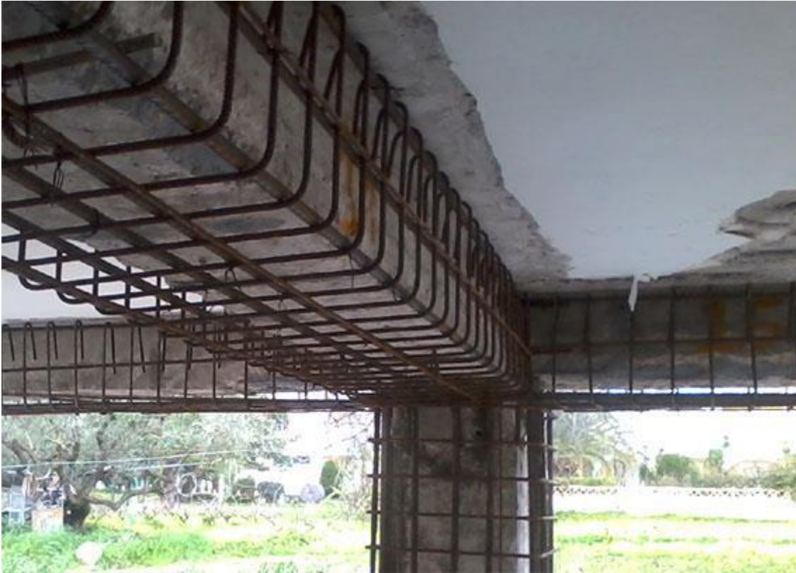
Εικόνα 5: Όπλιση μανδύα σκυροδέματος σε δοκό
