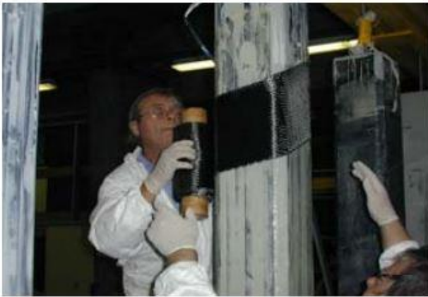
Εικόνα 12: Τοποθέτηση υφάσματος
