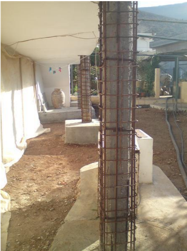
Εικόνα 4: Όπλιση του μανδύα σκυροδέματος
