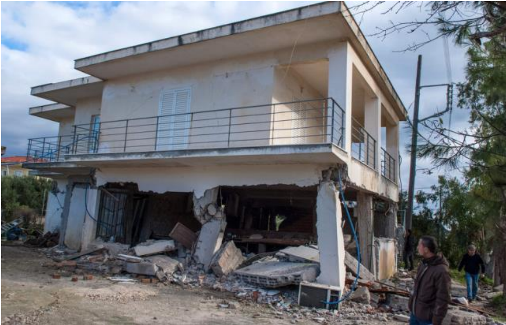
Εικόνα 2: Κτίριο υπό κατάρρευση μετά το σεισμό στην Κεφαλλονιά (Φεβρουάριος 2014)
