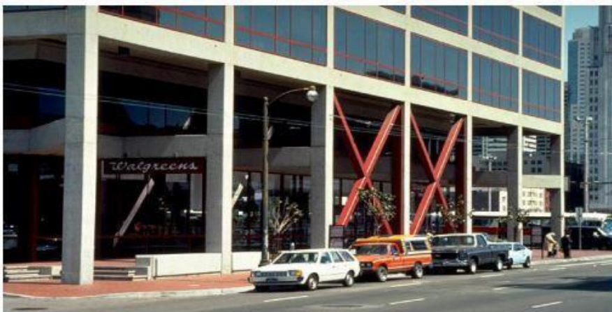
Εικόνα 14: Χρήση δικτυωτού χιαστί συνδέσμου σε πολυώροφο κτίριο
