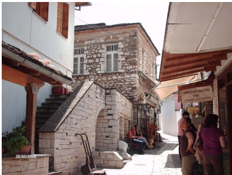
Εικόνα 59: Εξωτερική λιθόκτιστη σκάλα που οδηγεί στον όροφο
