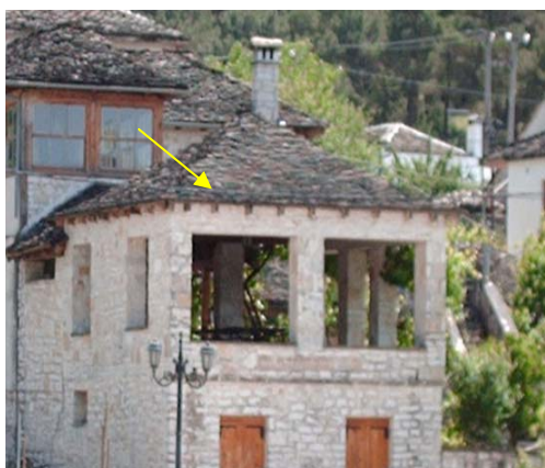
Εικόνα 57: Φουρούσια κάτω από στέγη για στήριξη και διακόσμηση
