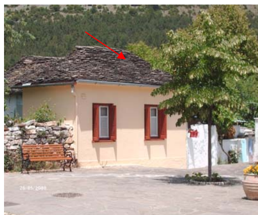
Εικόνα 58: Τετράρριχτη στέγη από μαυρόπλακες
