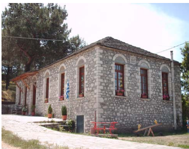
Εικόνα 18: Το δημοτικό σχολείο
