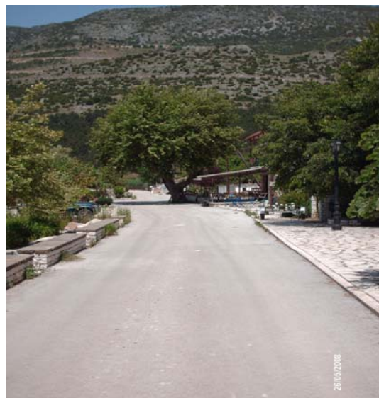
Εικόνα 35: Ο περιμετρικός δρόμος με άσφαλτο
