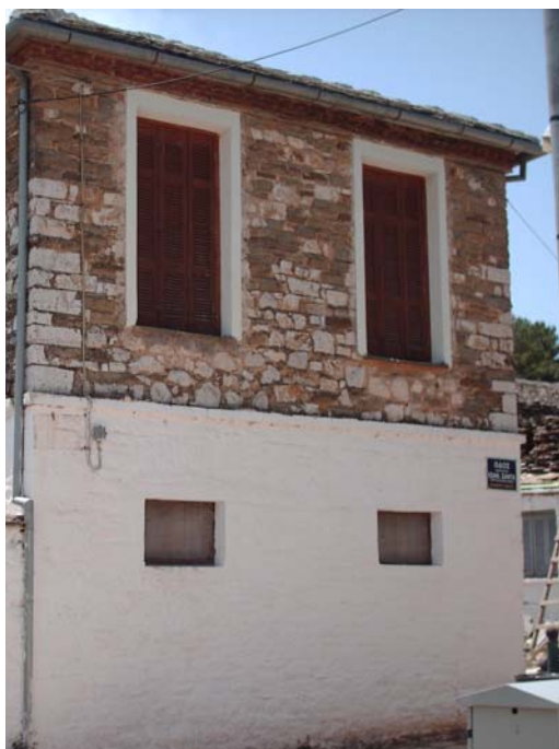
Εικόνα 50: Χαρακτηριστικοί φεγγίτες στο ισόγειο και στον όροφο
