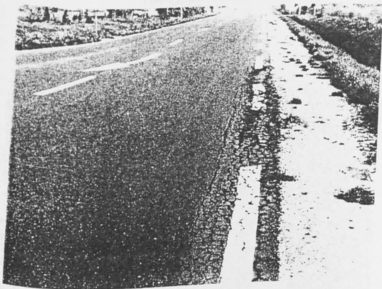
Ρηγμάτωση σε προχωρημένο στάδιο
