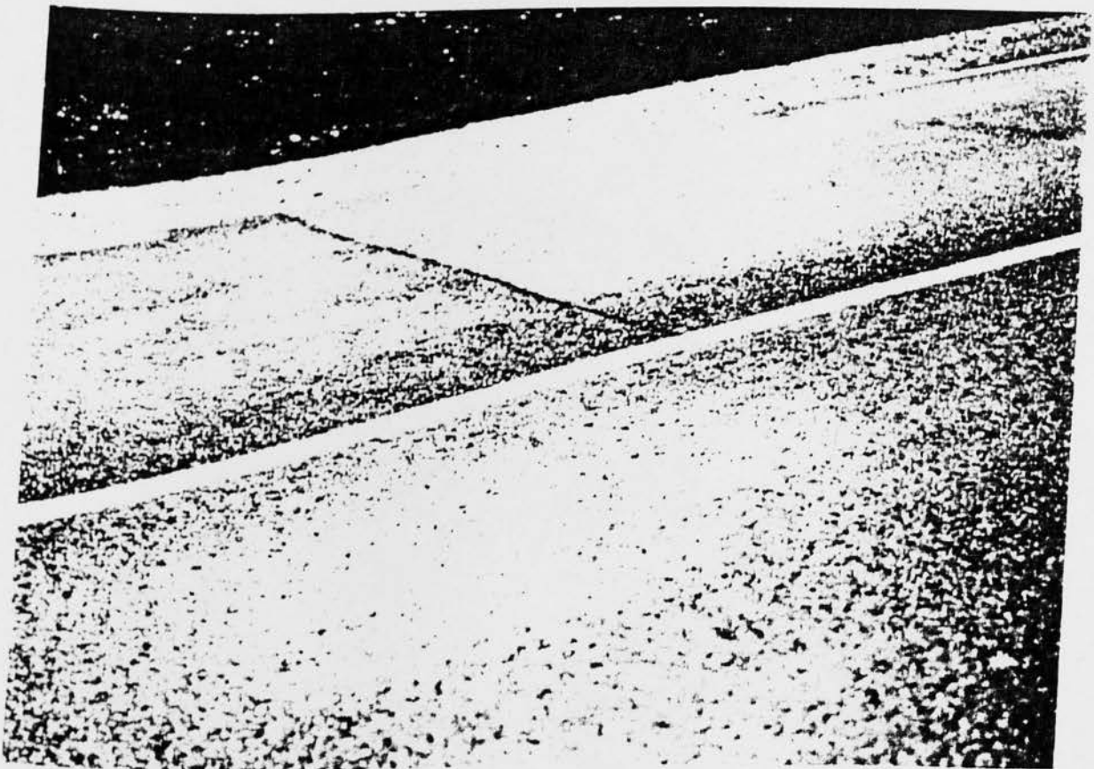
Εγκάρσια ρωγμή διακοπής εργασίας
