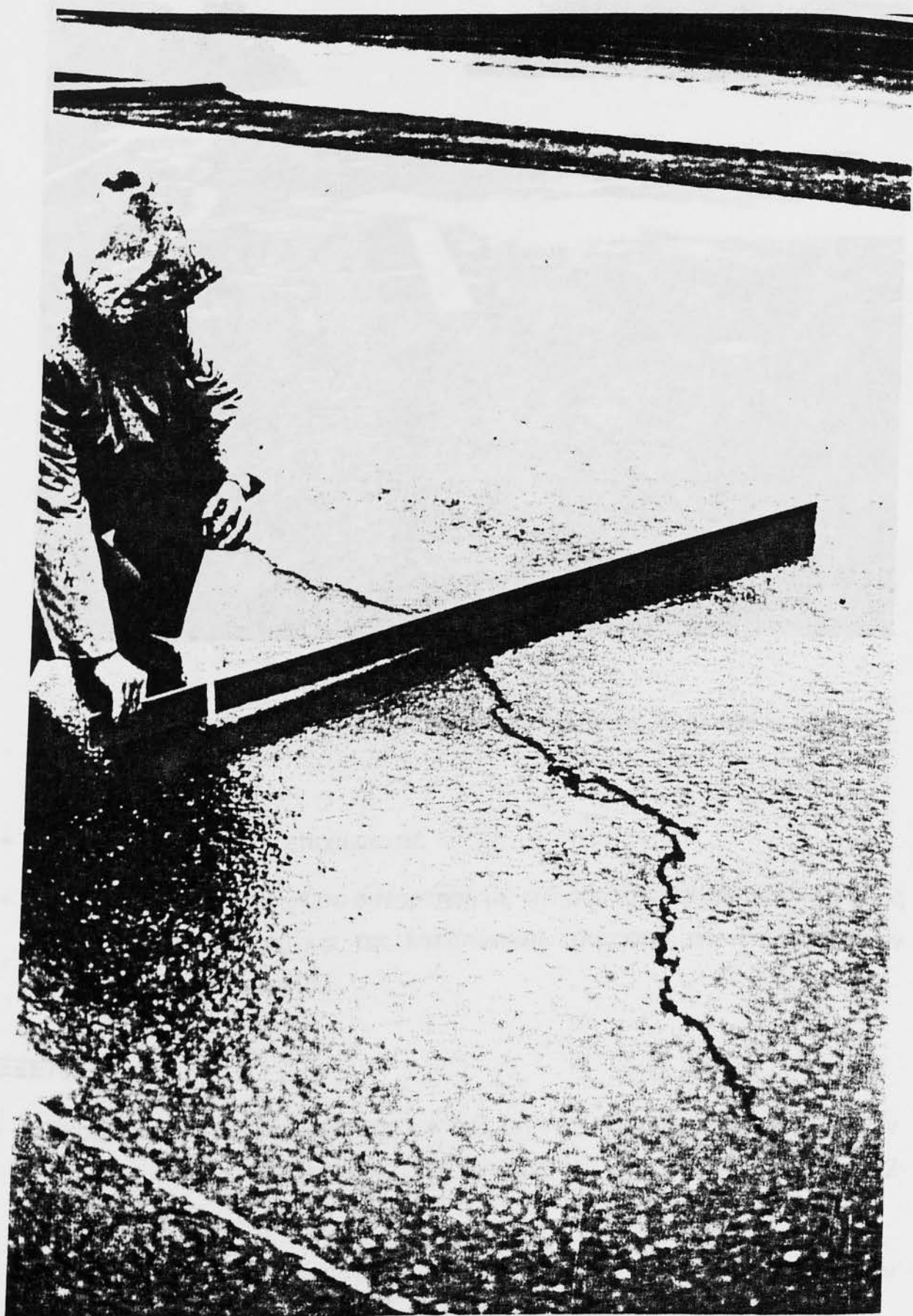
Ρωγή από ολίσθηση ποδιού επιχώματος (ο κανόνας δείχνει την ανισοσταθμία των άκρων της)
