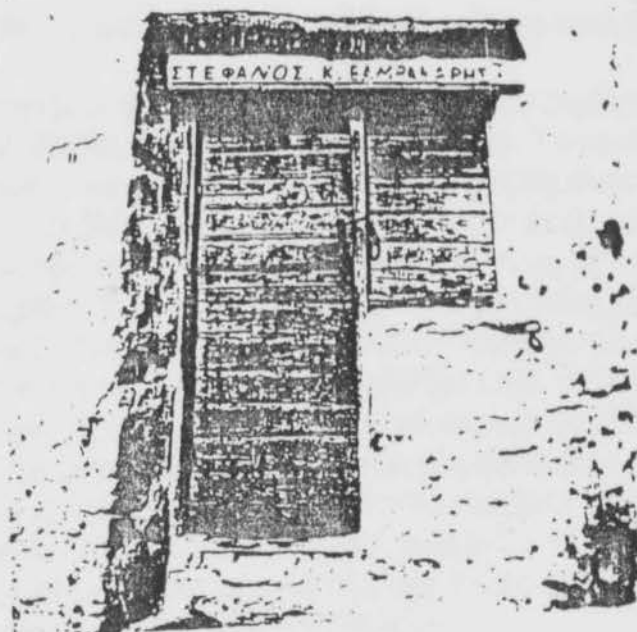
Λεπτομέρεια όψης καταστήμα- τος. Το άνοιγμα της πόρτας με το άνοι- γμα του παραθύρου είναι ενωμένα σ' ένα ενιαίο χωρίς λάμπα στη μέση άνοιγμα
