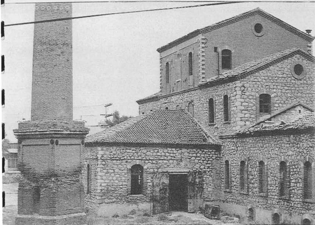
Τμήμα της πίσω όψης του κτιρίου υπό γωνία, που φαίνεται η ακριβής θέση της υψικαμίνου
