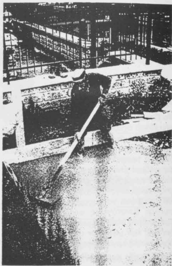
Εργασίες έκχυσης και φινιρίσματος του σκυροδέματος με RHEOBUILD 700. Δοσολογία τσιμέντου 250 kg/m 3
