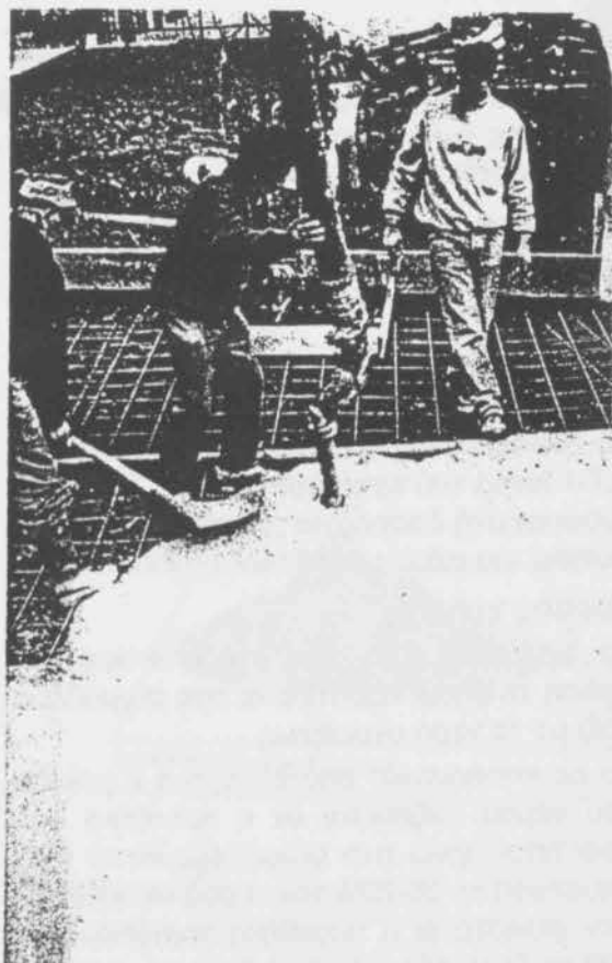
Εργασίες έκχυσης και φινιρίσματος του σκυροδέματος με RHEOBUILD 700. Δοσολογία τσιμέντου 250 kg/m 3
