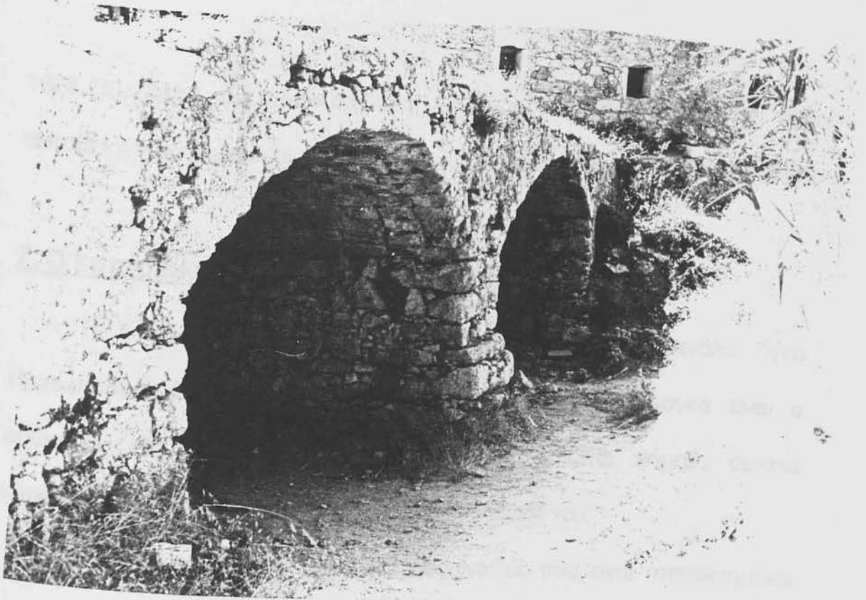
Φωτ. 13. Οι χώροι δίπλα στη δυτική πυλίδα.
