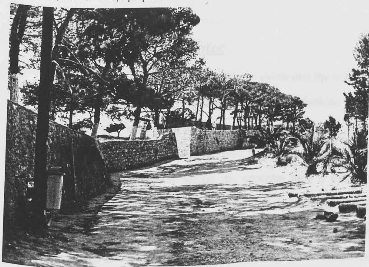
Φωτ. 10. Ο αναλημματικός τοίχος των επιχωματώσεων του νότιου περιβόλου της Φορτέζας.
