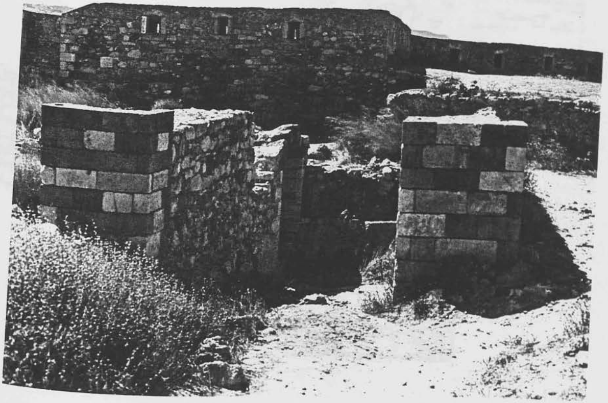
Φωτ. 12. Η δυτική πυλίδα της Φορτέτζας. Η εσωτερική πλευρά της στοάς της πυλίδας.
