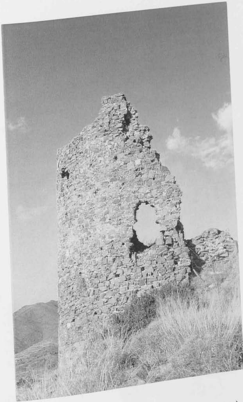
(Φωτ. 54: Πύργος παρακολούθησης αρκετά κατεστραμμένος)
