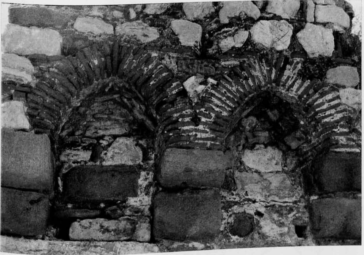
(Φωτ. 29, 30: Λεπτομέρειες – υλικά κατασκευής)
