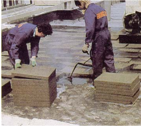
Εικόνα 8 α. Το κυψελωτό γυαλί σε δάπεδα και σε δώματα επικολλάται σε καθαρό υπόστρωμα με τη βοήθεια θερμής ή ψυχρής ασφάλτου. β. Πλάκες κυψελωτού γυαλιού διαφόρων παχών και σχημάτων.
