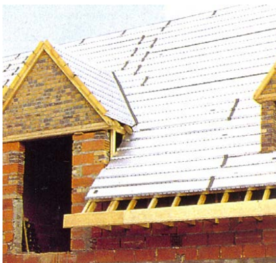
Εικόνα 45 Άκαμπτες μονωτικές πλάκες που παίζουν τον ρόλο πετσώματος σε στέγη.
